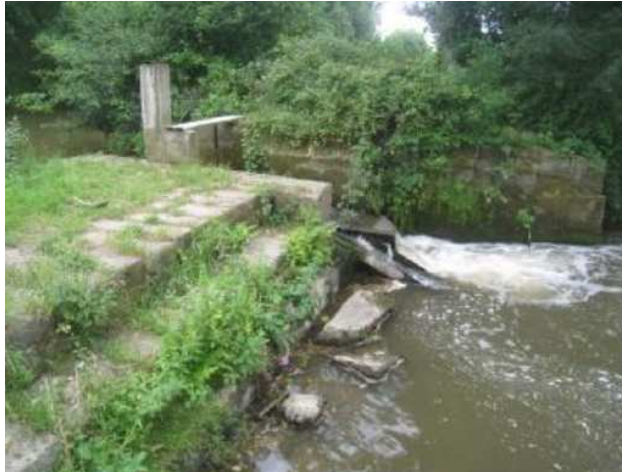
Le déversoir du moulin de Blot avant travaux
