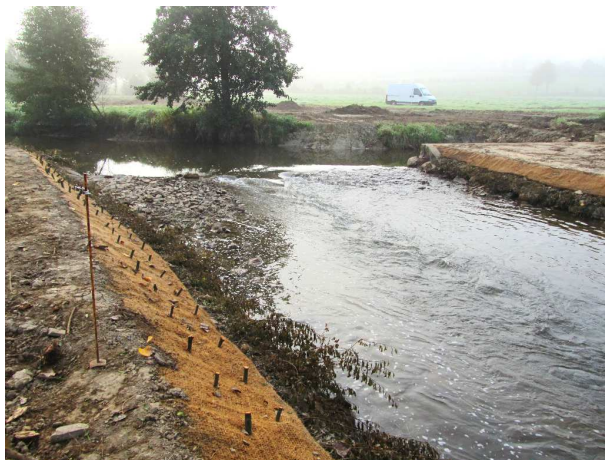
Le déversoir juste après les travaux
