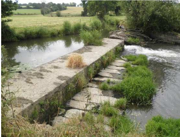
Le déversoir du moulin de Vendel avant travaux
