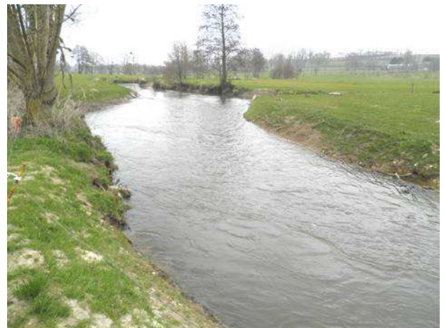
Le déversoir 6 mois après les travaux
