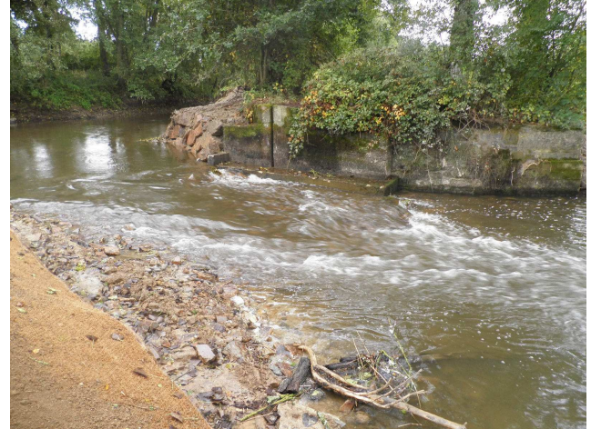
Le déversoir juste après les travaux
