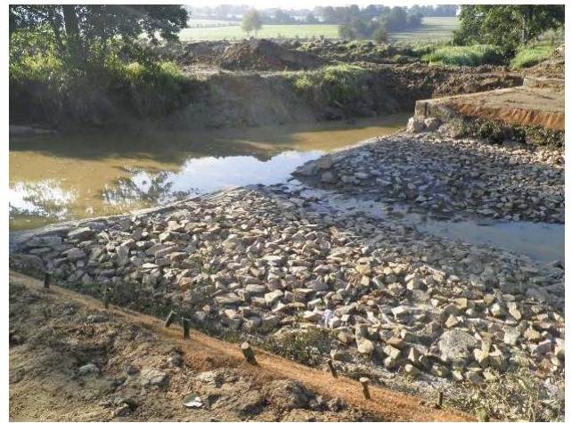
Le déversoir pendant les travaux
