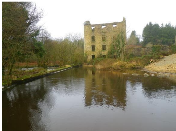
Etat initial du site : vue générale
