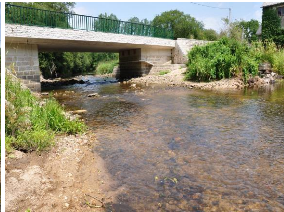
écoulement amont après travaux
