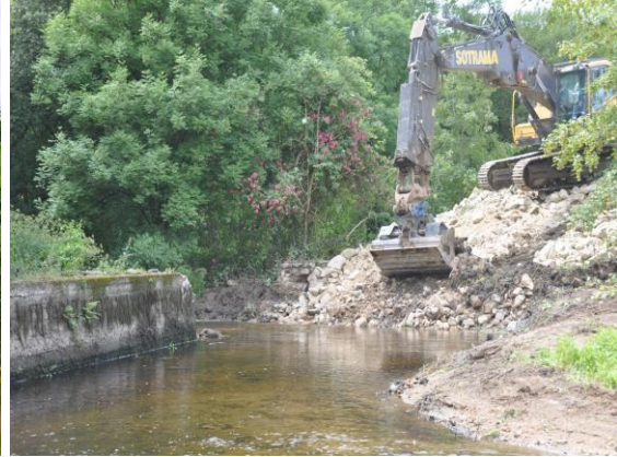
Remodelage de l'emprise du moulin
