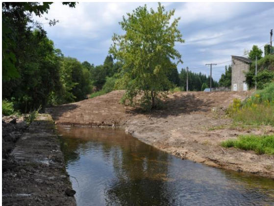
Vue générale du site à l'issue des travaux
