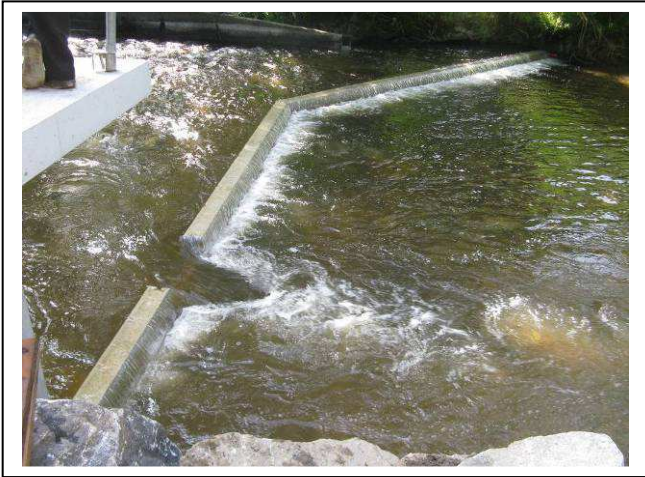
Reconstruction d'un seuil terminée, avec échancrure jusqu'au fond du lit.
