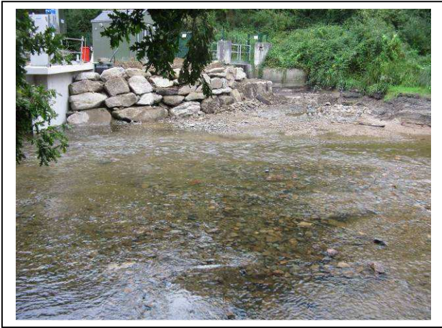
Démolition du seuil amont et création d'un radier pour rattraper la pente de la rivière.
