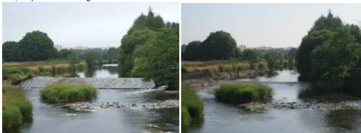
Seuil du moulin Conval avant et après travaux
