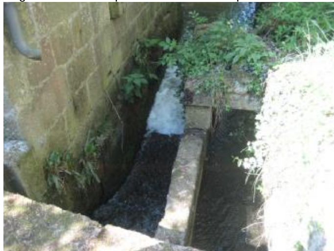
Vue des deux coursiers, coursier gauche en pied de bâtisse
