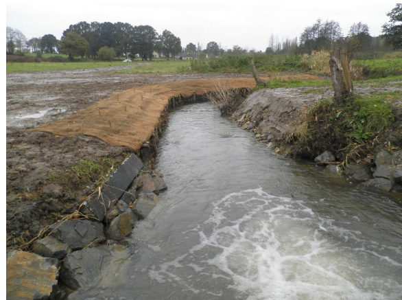
Le déversoir de la Motte après travaux : Création d'une rampe en enrochements et protection des berges en génie végétal.
