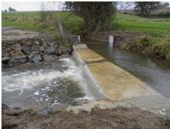
Le déversoir de la Motte après travaux : abaissment de 30 cm et création d'une échanturure de 30 cm.
