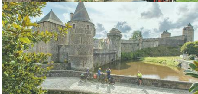
Restauration de la continuité écologique au niveau du château de Fougères pendant les travaux (à gauche) et après les travaux (à droite)
