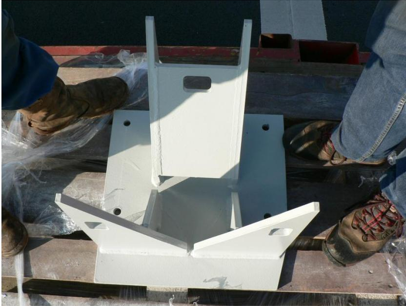
Photo 3.- Sabot de fond avec système de guidage du HEB.
