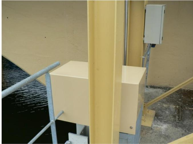
Photos 23 et 24.- Coffret protecteur de la structure porteuse du treuil et coffret électrique.
