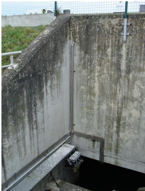
Photos 17 et 18.- Fourreaux inox de passage des câbles.
