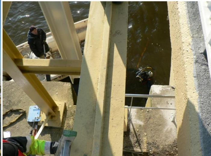
Photos 11 et 12.- Pose du HEB avec l'aide d'un plongeur.
