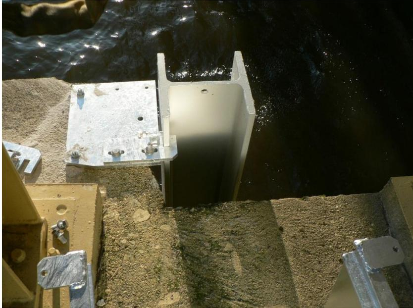
Photo 13.- Modification du positionnement du HEB dans l'échancrure.
