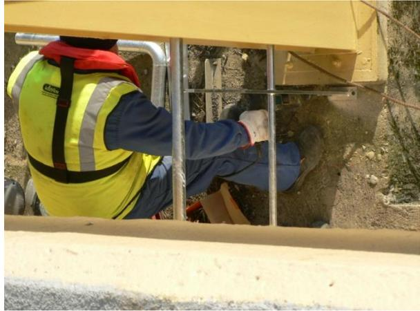
**Photos 5 et 6.- Pose des garde-corps sur la pile de pont n°4.**
