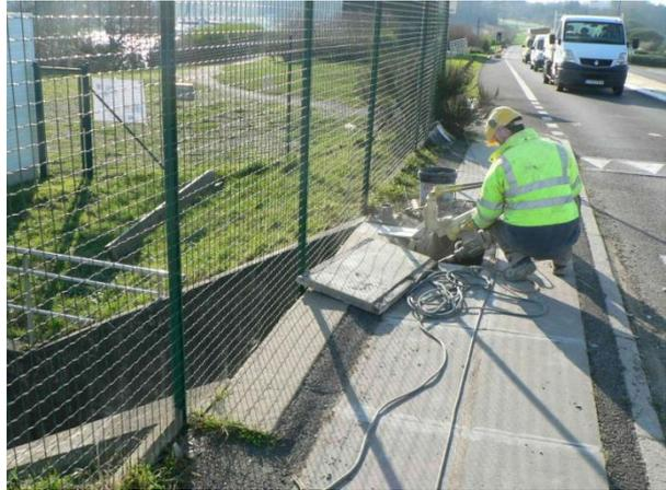
Photos 15 et 16.- Perçage des deux carottages pour l'accès au caniveau.
