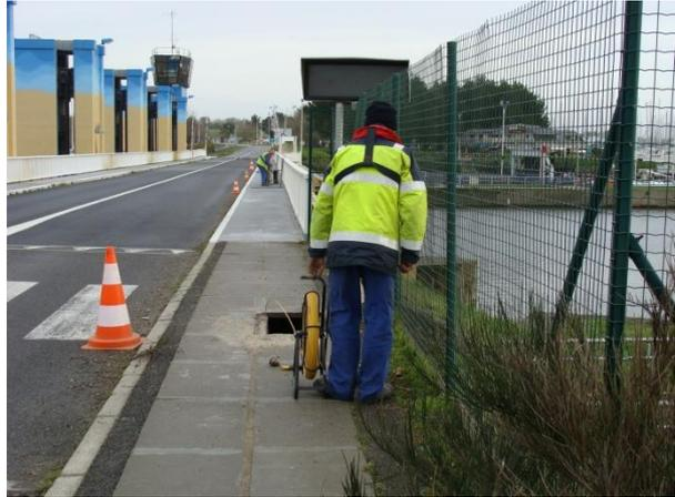
Photos 19 et 20.- Passage des câbles dans le fourreau de la pile n°4 et dans le caniveau du barrage.
