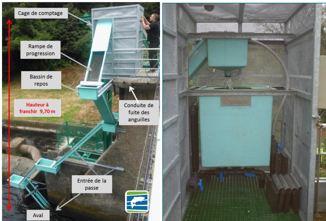
Figure 3 : A gauche, passe à anguilles composée de 5 rampes. A droite, vivier permettant le stockage des anguilles.
