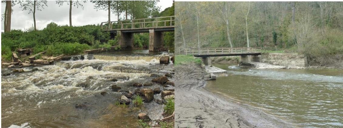
***Figure 15 : le moulin de l'Angle à Antrain avant et après travaux d'arasement***
