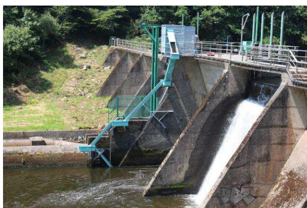
Passe à anguilles, dispositif de piégeage et ascenseur après travaux (Source : Eau du Morbihan)
