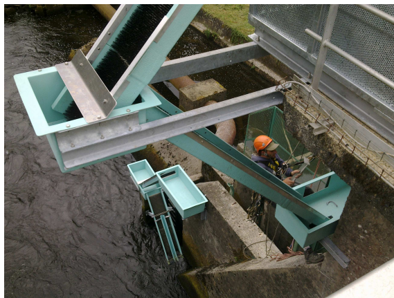
Barrage de Tréauray sur le Loc'h avant travaux ; installation des rampes à anguilles par cordistes (Source : Eau du Morbihan)
