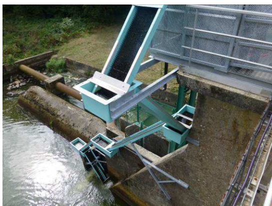
Barrage de Tréauray sur le Loc'h avant travaux ; installation des rampes à anguilles par cordistes (Source : Eau du Morbihan)
