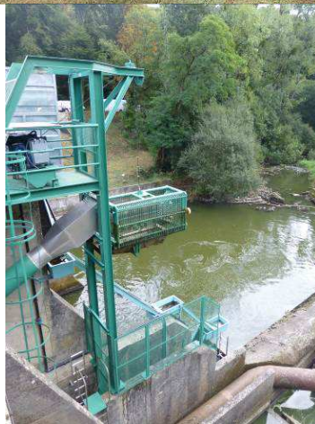
Passe à anguilles, dispositif de piégeage et ascenseur après travaux (Source : Eau du Morbihan)
