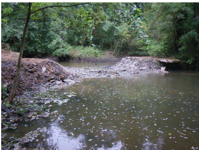
Vue du déversoir depuis l'aval juste après travaux : une zone de fosse naturelle existe à l'aval du déversoir
