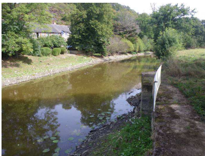
Vue du bief amont de Rochereuil après travaux (20/09/12)
