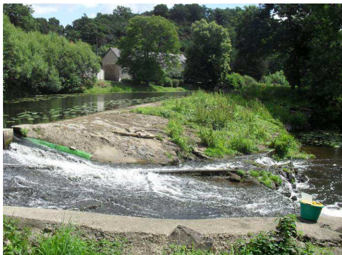
Vue du déversoir de Rochereuil avant travaux
