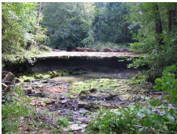
Vue du déversoir depuis l'aval avant travaux : l'eau ayant été pompée afin de travailler à sec
