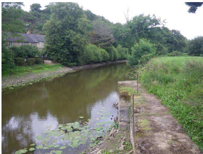
Vue du bief amont de Rochereuil avant travaux (10/07/12)
